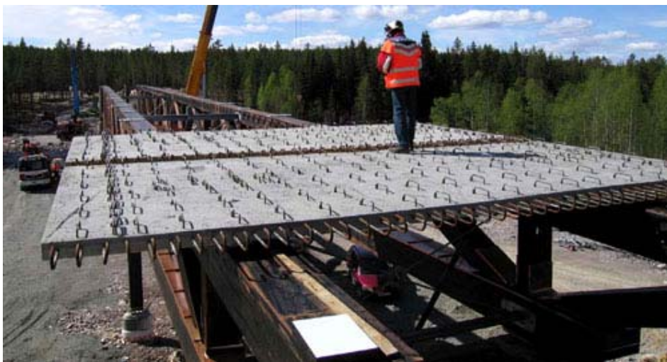
Gambar 5.14. Pemasangan lantai precast di atas jembatan kayu.
