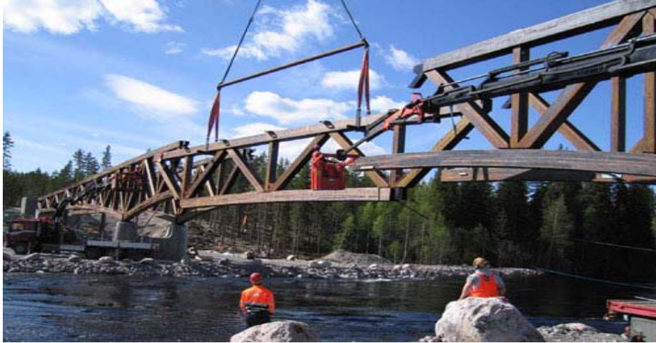
Gambar 5.13. Proses erection jembatan kayu sungai Rena
