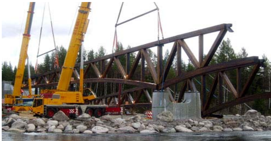
Gambar 5.12. Erection jembatan kayu laminasi.
