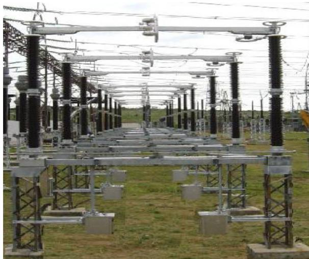
**Gambar 3.1 Lokasi Penempatan Saklar Pemisah pada GI**
