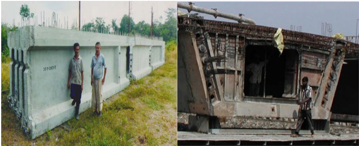
Gambar 2.31. Bagian ujung suatu gelagar kotak sesudah penarikan tendon
