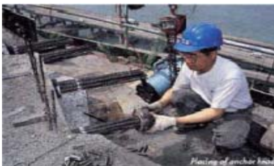
Memasang blok anker dan pasak-pasak
