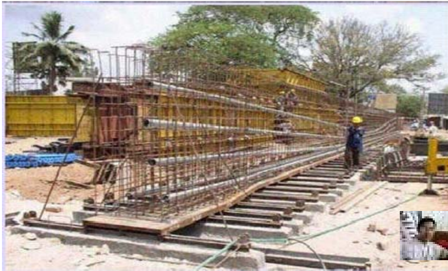
Gambar 2.45 Perakitan/Pemasangan pendetailan tulangan non pratekan dan Tendon
