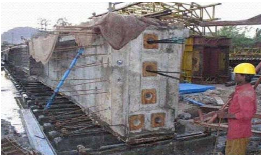
Gambar 2.46 Memasukkan tendon (kabel) kedalam pipa / saluran
