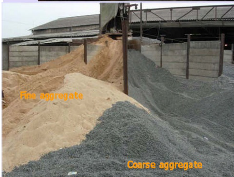
Gambar 2.19. Penyimpanan material agregat halus dan agregat kasar
