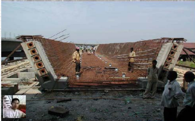
Gambar 2.48 Penarikan dan Pengangkuran tendon-tendon
