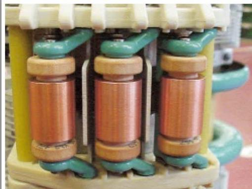
**Gambar 11.9 Sistem kontak saklar selector dengan roler**
